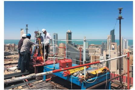
Control des coffrages des murs porteurs à l'aide d'une station totale utilisant les points actifs GNSS - Tour NBK au Kuwait
